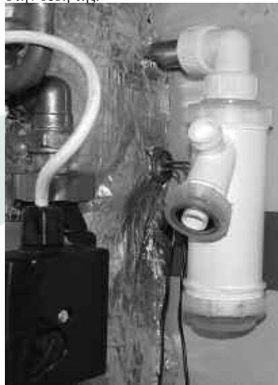
Εικόνα 6-3: Παγίδα Συμπυκνωμάτων
