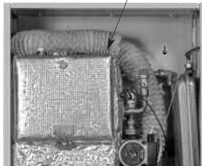
Εικόνα 4-13: Επανατοποθέτηση Αγωγού Αναρρόφησης
