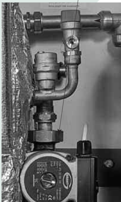
Εικόνα 4-4: Αφαίρεση Σωληνώσεων Προσαγωγής & επιστροφής
