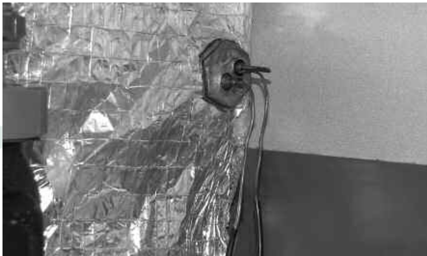
Εικόνα 10-3: Κυάθιο Θερμοστάτη
