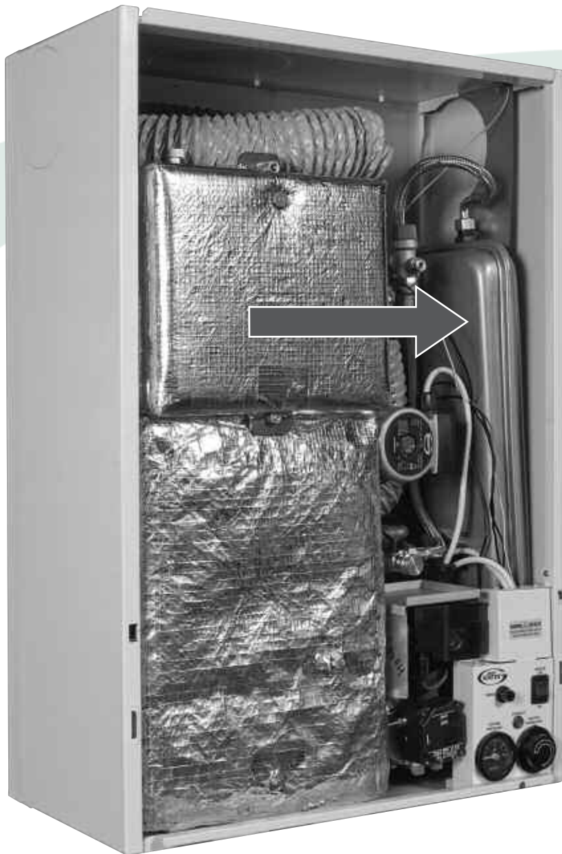
Εικόνα 7-3: Θέση Δοχείου Διαστολής
