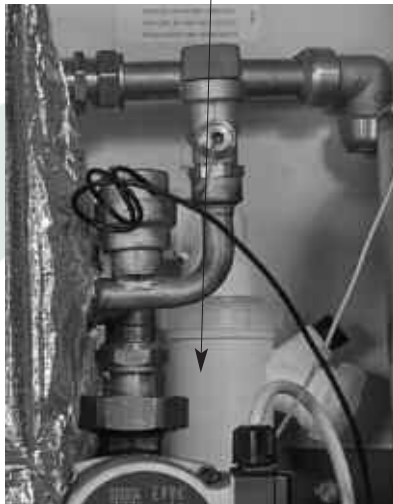
Εικόνα 4-12: Επανατοποθέτηση παγίδας Συμπτκνωμάτων
