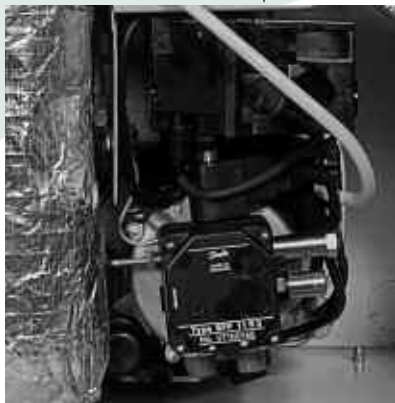
Εικόνα 4-5: Αφαίρεση Καυστήρα
