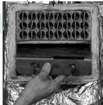
Εικόνα 4-7: Αφαίρεση Διαφραγμάτων από τον Λέβητα
